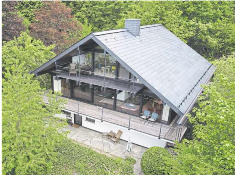
Zurück zur Natur: Nach der Entfernung der asbesthaltigen Eindeckung aus den 80er Jahren entschieden sich die neuen Besitzer für eine moderne Rechteck-Deckung aus Schiefer. Die Unterkonstruktion konnte bei der Sanierung kostensparend erhalten bleiben. Fotos: Rathscheck
